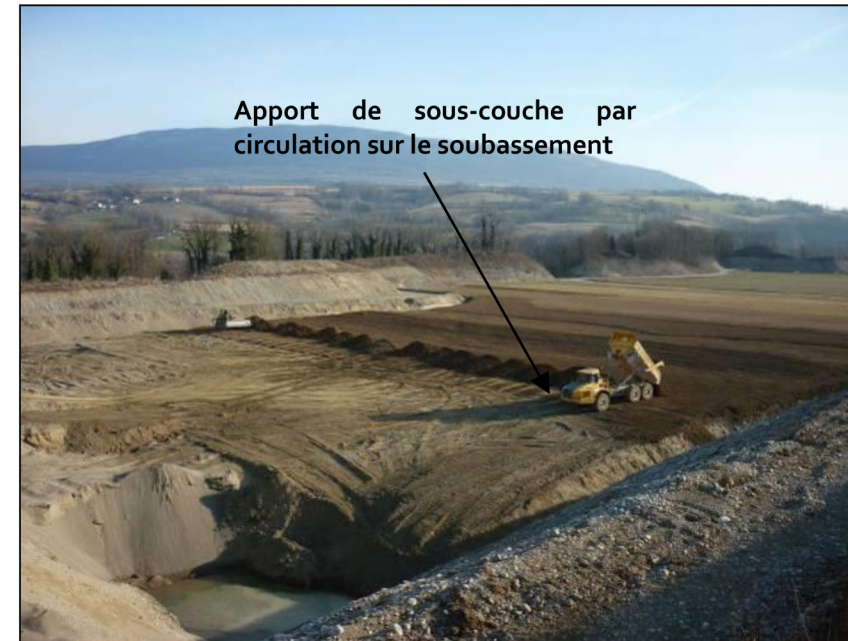
Remise en place des matériaux terreux : dépotage de sous-couche et rippage du soubassement
